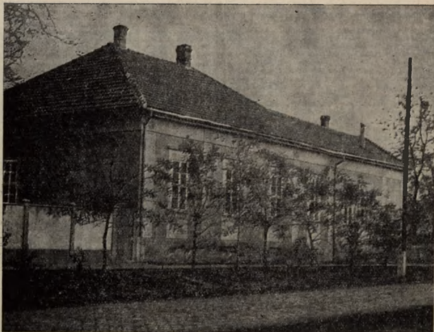
A kevermesi római katolikus plébánia épülete 1964-ben, mely felépítése óta csak tetőzetében változott
