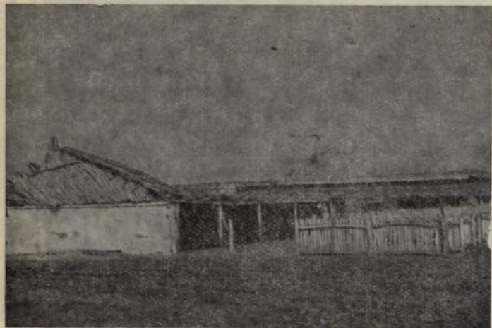
1963—1964 telén összedőlt a gyengén megépített szerfás ól („Vörös Csillag”)
