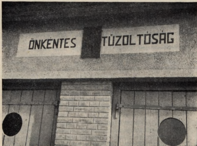
Az új tűzoltószertár homlokzata
